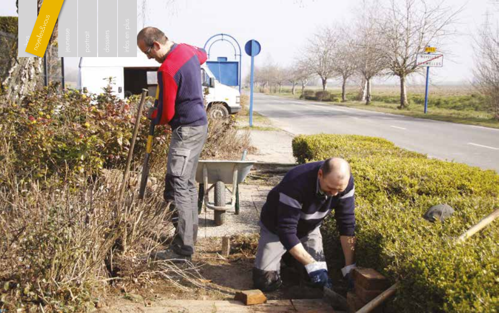
Bernard Pezé et André Crampon sur le chantier du dallage des trottoirs, Rue des Résistants
