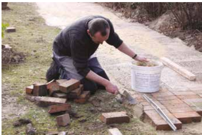
Christian Martin sur le chantier du dallage des trottoirs de la Rue des Résistants
