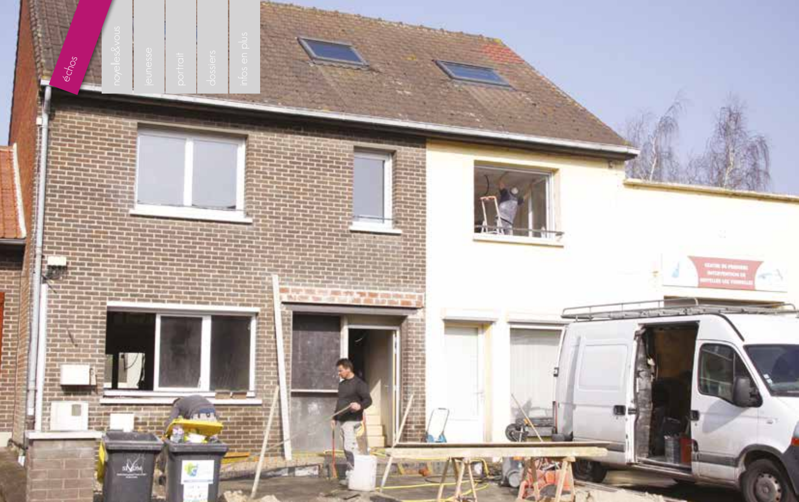
La société BROUTIN en train de confectionner la rampe d'accès de « L'Etape Noyelloise »
