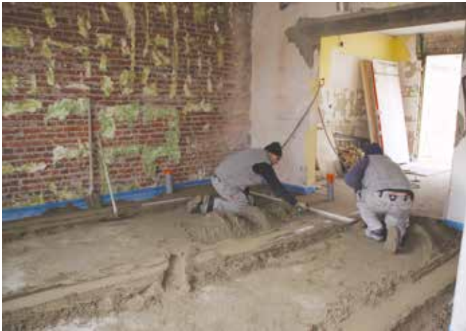
La société BROUTIN en train de re-cr  er la chape du rez-de-chauss  e
