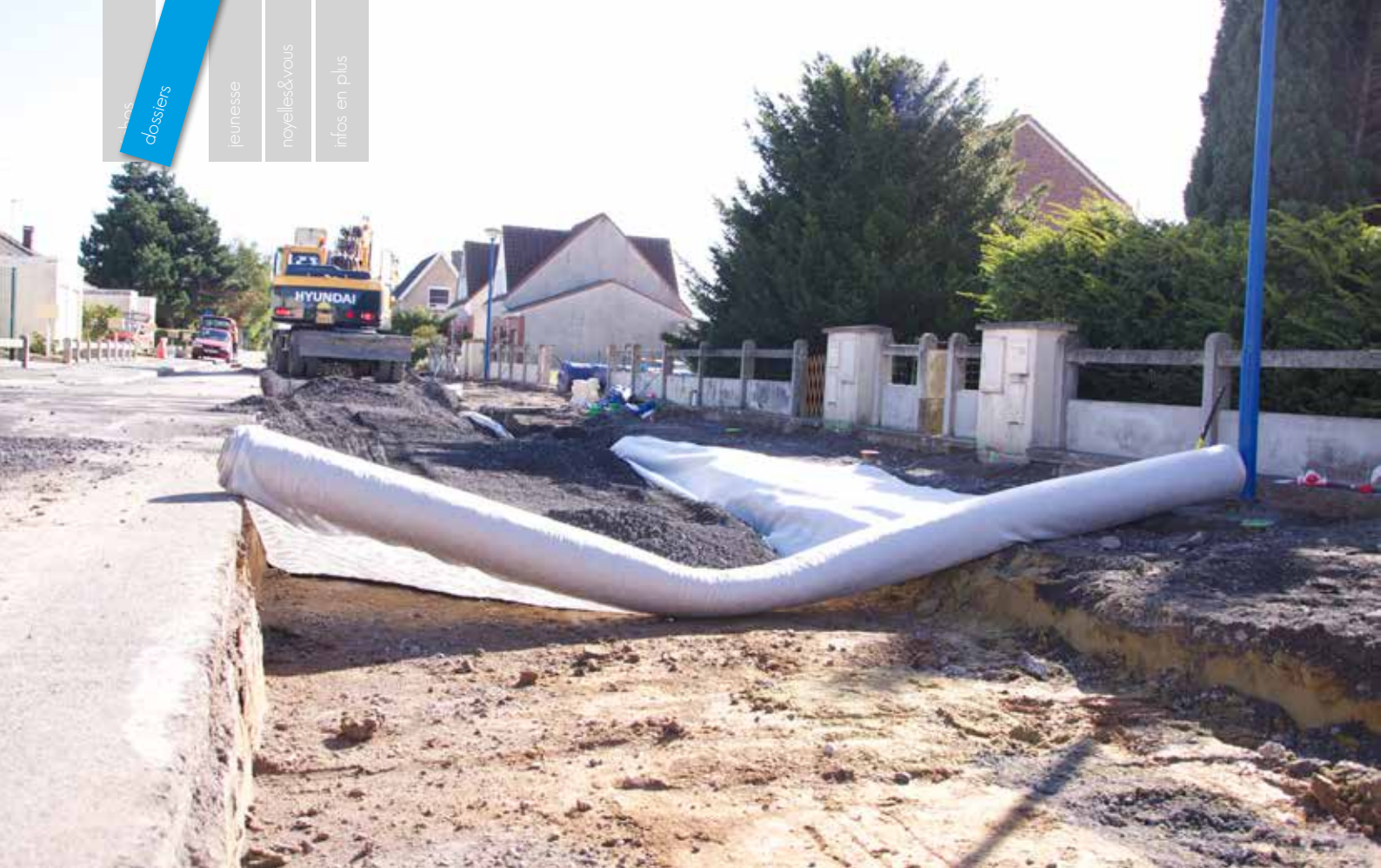
Route de Vermelles, les travaux ont commencé début septembre
