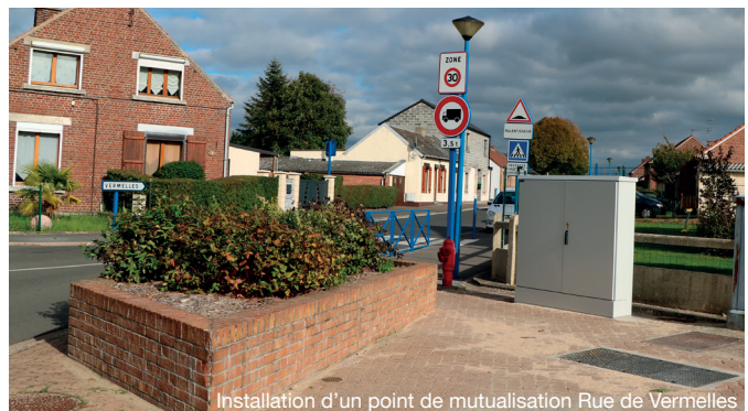
Installation d'un point de mutualisation Rue de Vermelles
