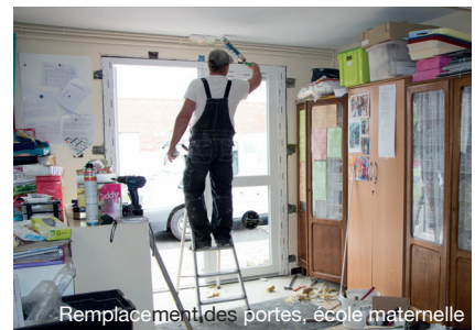
Remplacement des portes, école maternelle
