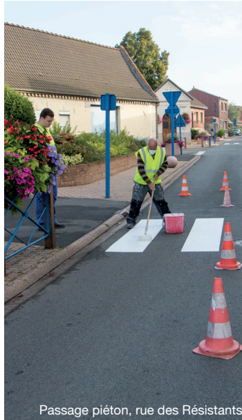
Passage piéton, rue des Résistants
