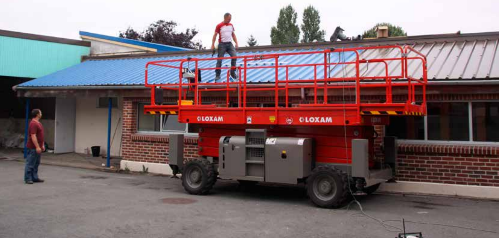
Pose de panneaux isolants en bac acier par l'entreprise SRCE.
